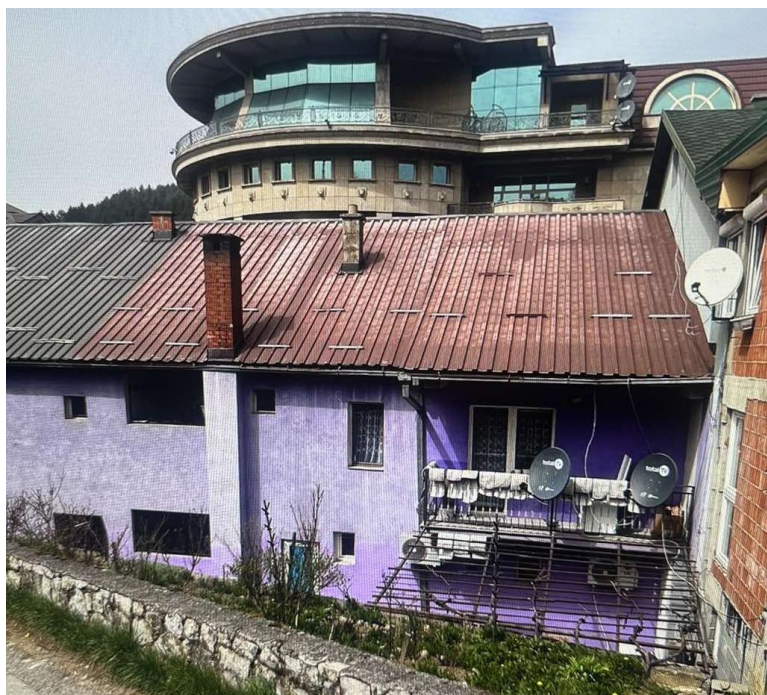
Slika3. Postojeće stanje objekta
