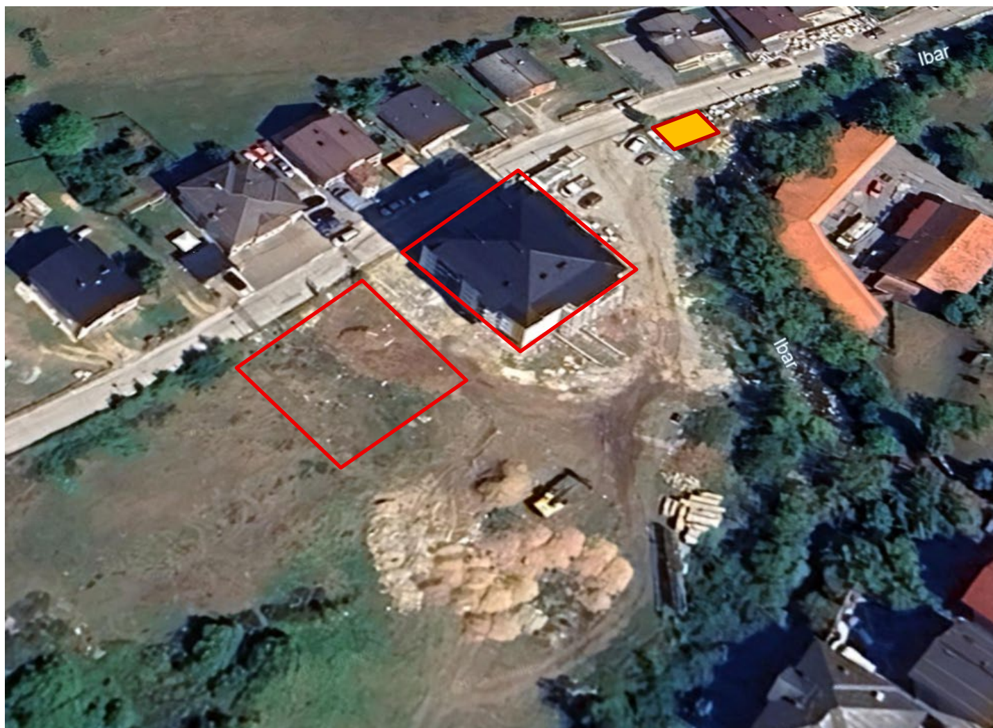
Slika 2. Lokacija TS u KO Ibarac I, opština Rožaje (pozicija buduće trafostanice označena je poligonom u žutoj boji) (pozicija postojećeg objekta i objekta u izgradnji predstavljen je pravougaonikom obojenim crveno)
