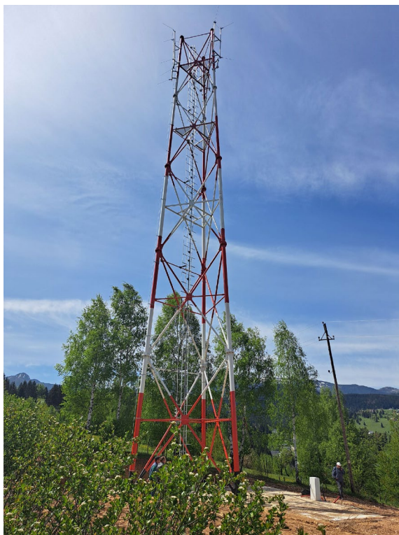
Slika 3.1. Izgled izvedenog stuba
