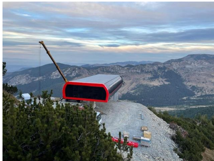
Slika 1. Izgled lokacije gdje se planira izgradnja trafostanice
