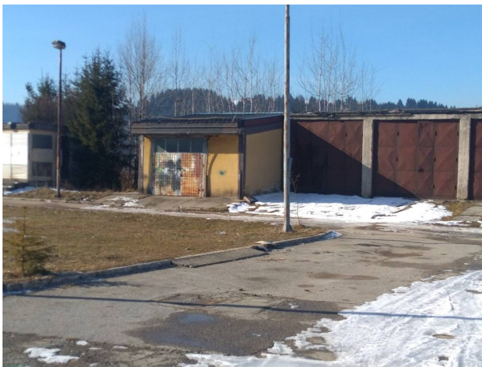
Pilazni put do objekta i trafostanica
