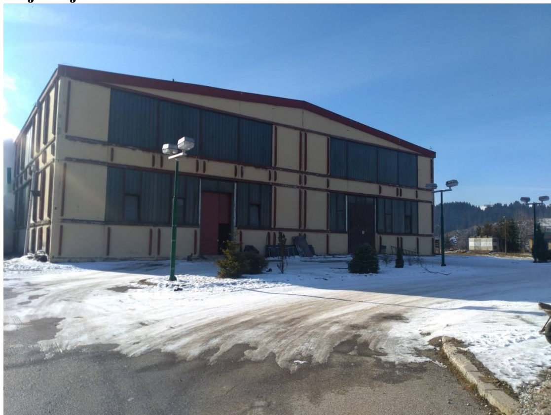
Izgled objekta u kojem je instalirano postrojenje za proizvodnju peleta
